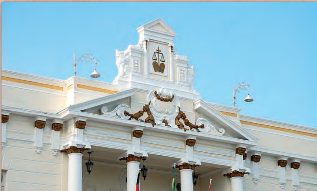
Detalhe da fachada do prédio do TJPB: arquitetura exuberante.
